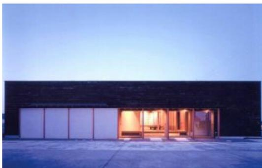
小規模の公民館建築であるが、集成材の陸梁を主体とする塾考された構造を用いることによって、四十畳の無柱空間を確保するとともに、主室を付属室に傾けて対させて変化に富む半戸外的土間空間を創造している。直方体的な抽象的外観に黒染下見板を張って周囲の伝統的家屋の形態との連続性を保っている。小さな角塔状の消防器具庫がランドマーク性を与えている。
