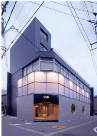
築三十年の鉄骨造料理店のリニューアルである。既存構造を残し、それを新設の打放しコンクリート壁及びガルバリウム鋼板で覆って新しい現代的外観を与え、解体費用を抑えるという選択と手法が優れている。外壁と客席の間、また客席間に、伝統的意匠をモダナイズした造形の庭と通路、水底という中間領域を配した内部空間構成が巧みである。
