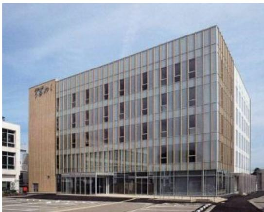
築約20年の鉄筋コンクリート造事務所建築の文化研修施設へのリニューアル/コンバージョンである。前面部に1スパンの増築を行って、ロビーとその吹抜け空間、工房、会議室等の空間を確保し、既存部分に展開する展示、研修、演劇/舞踏練習場等に十分な面積を与えること、さらに前面に新しいファサードを創って、建築に全く新しい外観を与える計画、造形が優れている。
