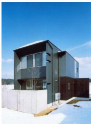
一階に寝室、客室、浴室などの閉鎖性が要求される諸室を置き、高さによって周辺からの視線を避けるために、二階にリビング、ダイニング、キッチンをワンルームとして配置し、北面の壁全面を開口して、広闊な眺望を可能にした構成が優れている。ガルバリウム鋼板縦ハゼ葺を用いた直方体の外観構成、また内部のディテールの収まり等は精緻な構成である。
