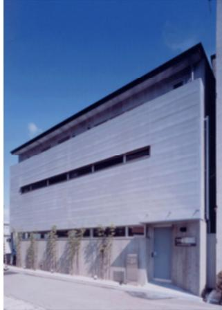
交通の頻繁な前面道路、左右及び背面が駐車場及び隣接建築に密接した狭隘な敷地という悪条件に対して、前面及び右側面に最小限の開口を持つRC造壁を立ち上げて前面道路からの騒音を遮断し、プライバシーを確保した閉鎖的で親密な空間を創っている。背面、左側面に住宅部へのアプローチとなる領域を設定し、これを室内、室外を繋ぐ中間領域として、これに向けて室内空間を開き閉鎖性を軽減している。悪条件を逆手にとった良質の解決が評価された。
