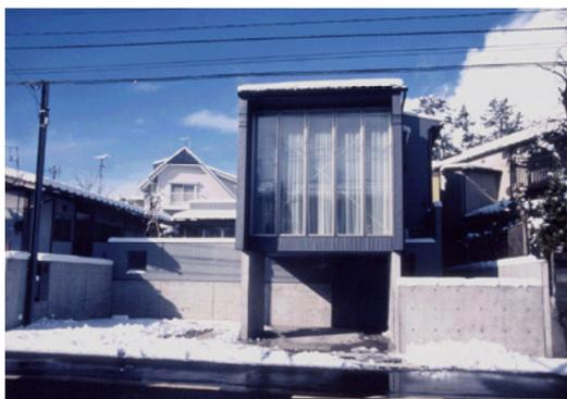
介護が必要な祖母、母、息子夫婦のための三世代住宅であるが、世代別の生活空間を相互間に適切な距離を持った半独立的な空間として巧みに連携させたプランニングが優れている。敷地面と道路との間の1.2米の高低差を利用して居間を2.15米高のピロティに載せ、その下を潜って斜路で玄関へ導く介護に配慮したアプローチも評価される。このことが居間を一階床から72センチ上がるスキップフロアにしている、一階、居間、その吹抜けから二階へ連なる空間のシーケンスの快い変化を産み出している。
