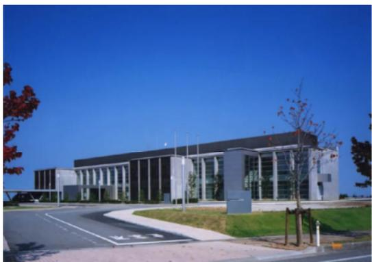
南面する廊下に沿って試験研究室を並べ、廊下の反対側に事務諸室をファサードから突出した形で配置するプランニングが明快である。南面はガラスカーテンウォール、北面は研究室のパイプシャフトスペースの箱状壁を並べた構成の対比的なファサード構成が成功している。多様な研究に対応すべく考慮された設備計画が優れている。
