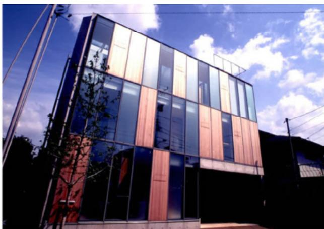
透明、半透明、不透明な矩形パネルで構成された四枚の平行な壁による空間。その壁に による設備空間と居住空間の明確な分節を創るためのコンクリートおよび鉄骨造の混構造手法、またそのディテールに優れている。
