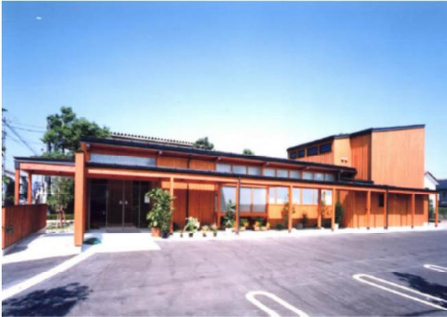
表通りから3.5mセットバックして、植栽のあるポケットパーク的な魅力的な空気を設け、通りの歩行者空間に大きな寄与をした。屋根を寄棟として軒の線など水平線を強調する造形で、道路からの視線に快い景観を創っている。
