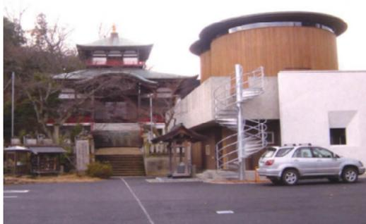
伝統的様式を用いず現代のデザインで仏寺を設計し優れた造形を生み出した。杉板貼の円筒を二個接合して並べた 護摩堂、背後の伝統様式の既存本堂、それらを調和させるために中間に置いた黒い方形のギャラリーというシークエンスの造形が成功している。護摩堂のインテリアも新しい仏寺宗教空間の可能性のひとつを提示したものである。
