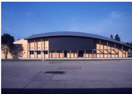
集成材で架構した片流れ屋根のそのままでは変哲のない単純な大空間を、屋根を南北方向にむくらせることと、正面に斜めに張り出させ北妻も斜めに掛けることで、屋根外観に球面の様な印象を与えて、ユニークな外観に見せている。ポーチ・コロネードの在来軸組構造的デザインが、この建築が木造であることを宣言している。
